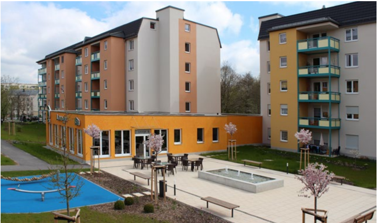
Beispiel Wohnpark „Am Bernsdorfer Bad“ mit CSg-Lounge [Quelle: CSg]
